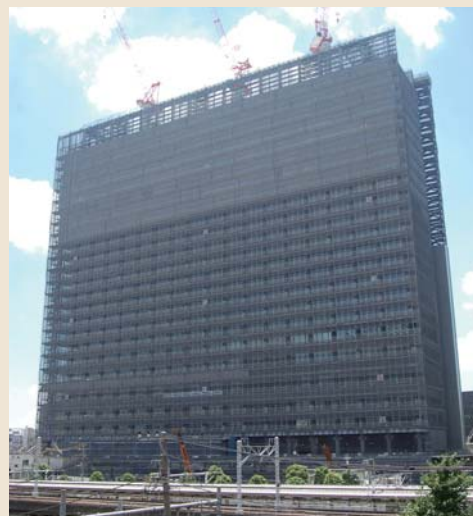
現場におけるユニット施工の途中
