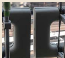
ルーバージョイント部
